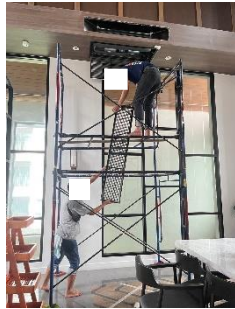
ภาพที่ 2-52 การทำความสะอาดเครื่องปรับอากาศ
