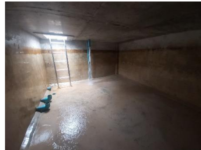
ภาพที่ 2-17 การตรวจสอบและทำความสะอาด ถังเก็บน้ำใต้ดิน
