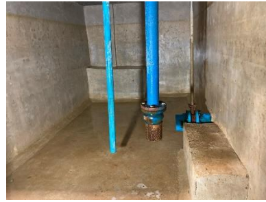
ภาพที่ 2-17 การตรวจสอบและทำความสะอาด ถังเก็บน้ำใต้ดิน
